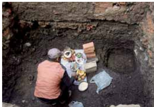
Ritual zum Baustart des Potteryhomes – mit Ton, rohem und gebranntem Ziegel. Auch Werkzeug wird gesegnet.
