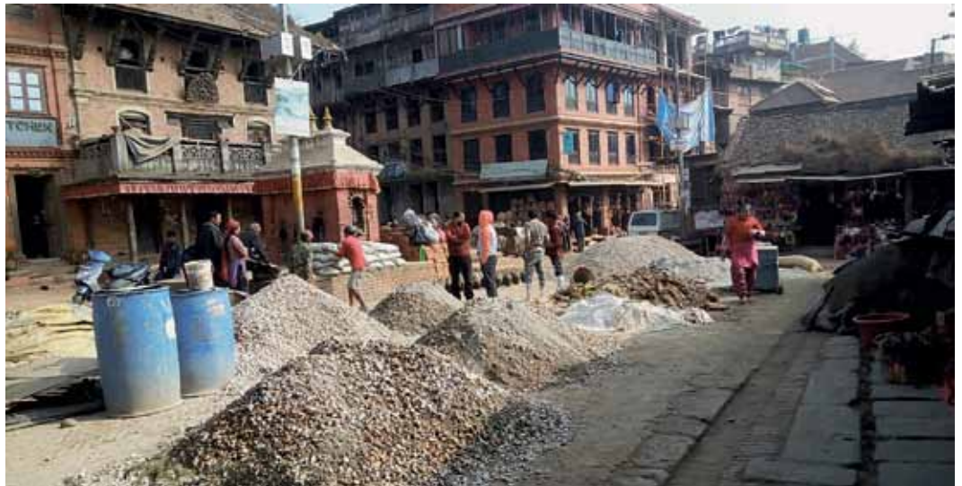
Ab Dezember 2017 wird der Pottery Square zur Baustelle, denn diverse Häuser werden neu aufgebaut.
